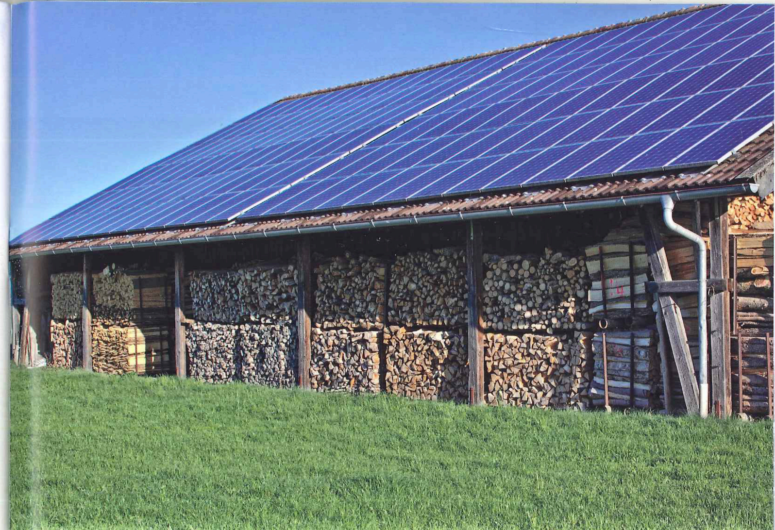
Impianto fotovoltaico per la produzione di energia elettrica sfruttando l'energia solare
