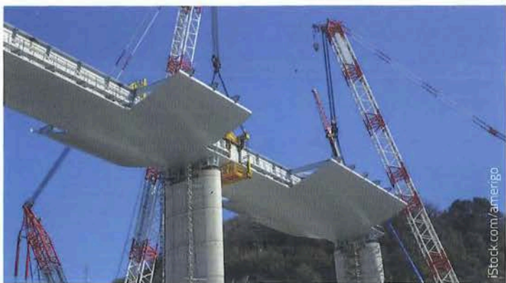
Costruzione del nuovo ponte sul fiume Polcevera
