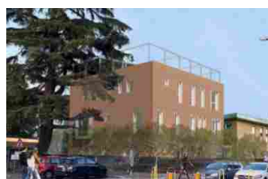
Lavori in corso per la Casa Comunità di Busto Garolfo
