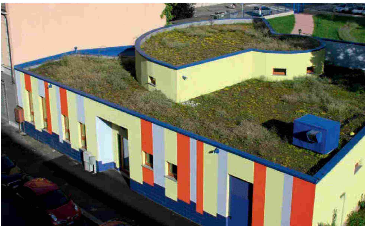
La copertura verde del tetto piano aumenta l'isolamento termico e acustico, maggior inerzia termica e diminuzione dell'isola di calore anche per gli edifici vicini e utilizza le acque di pioggia per irrigare naturalmente il Sedum, pianta molto rustica dalle minime esigenze manutentive. (Foto Marco Minari)
